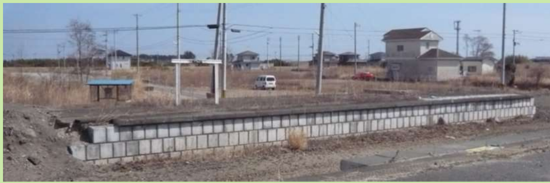
旧山下駅に残されたプラットフォームの痕跡
