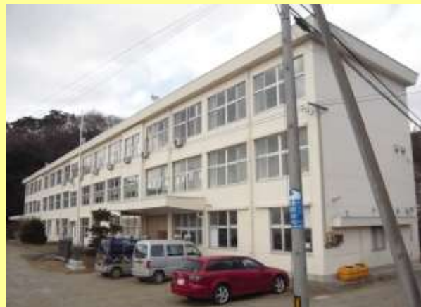
野蒜小学校に残された津波高さの標識
