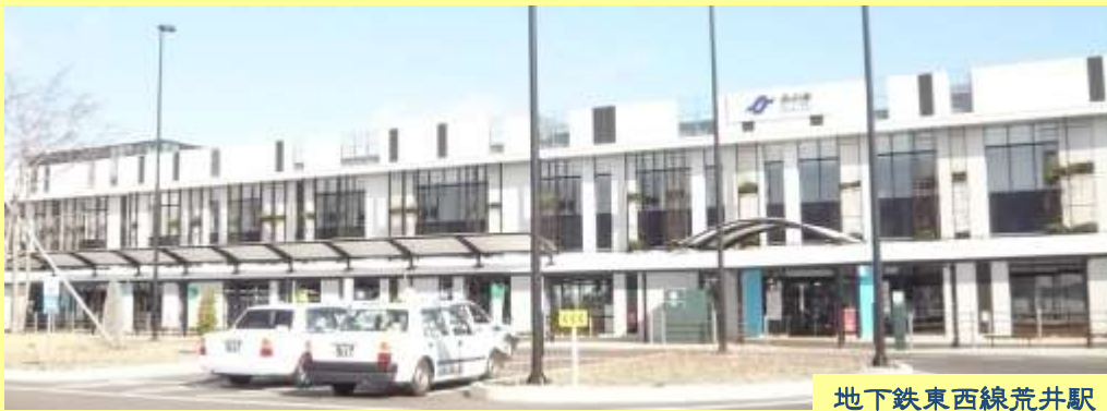
地下鉄東西線荒井駅
