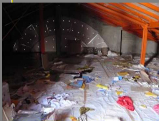
緊急避難場所となった屋上の屋根裏部屋
