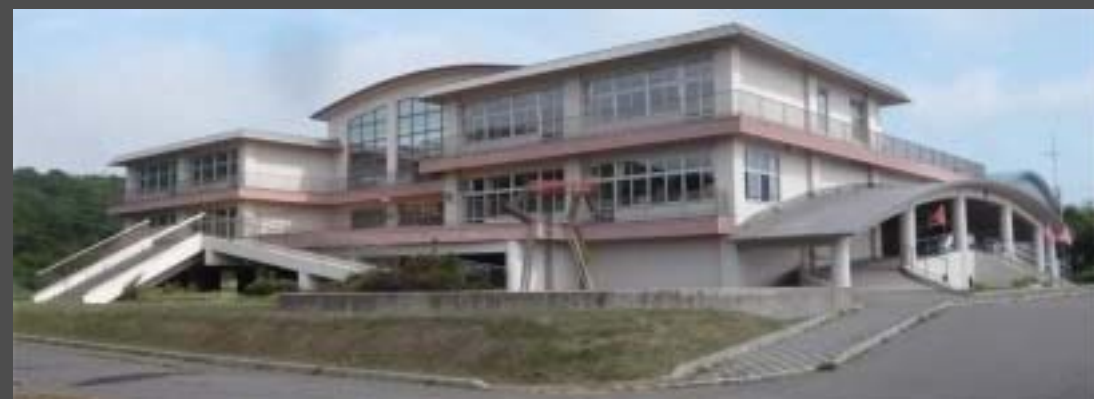
1階部分をそっくり嵩上げした青苗小学校
