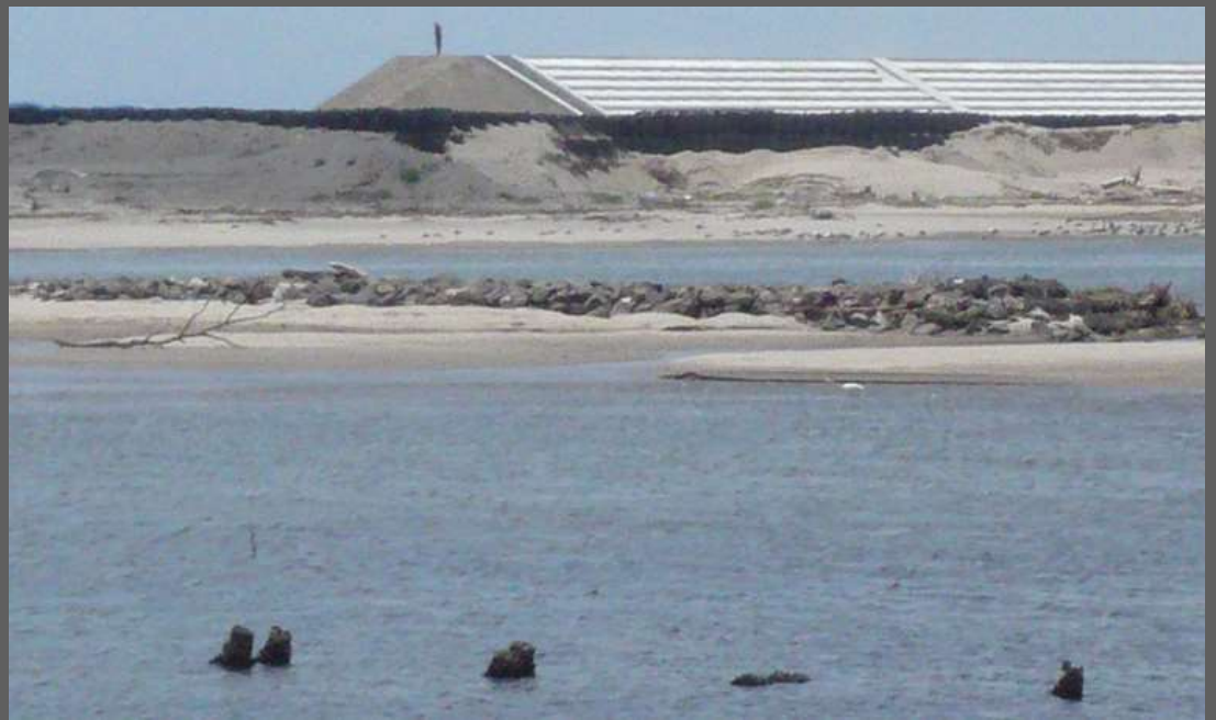
七北田川右岸に建設中の防潮堤 [撮影. 2013. 7. 19]
