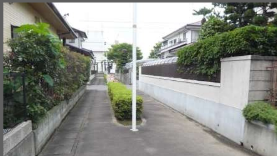
周辺民家での津波浸水高は70cm程度
