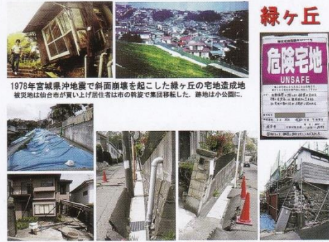
写真4 仙台市太白区緑ヶ丘地区における地震時の地盤被害 (上段：1978年宮城県沖地震，下段：2011年東北地方太平洋沖地震，写真撮影は全て筆者による)
