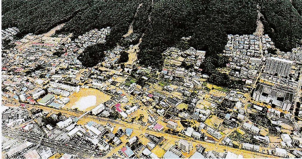
写真1 土砂崩れが発生した広島市安佐南区の現場 [3]
