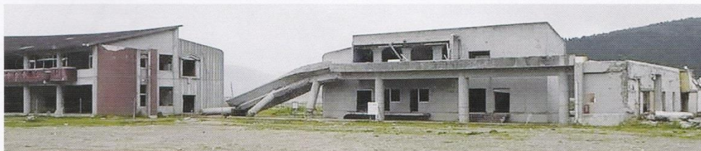
写真24 津波で押し倒された渡り廊下(2013.6.1.撮影)
