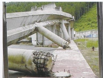
写真27 2階から見た渡り廊下(2013.6.20.撮影)
