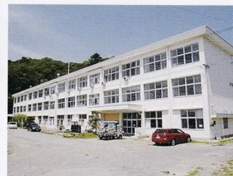
写真18 高さ5mの津波に襲われた野蒜小学校(2013.6.1.撮影)
