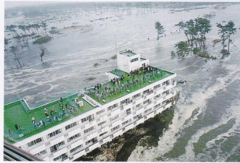
写真01 荒浜小学校の屋上に避難した被災者（仙台市 [12]による） 地域住民を含めた320人が校舎に避難していた。
