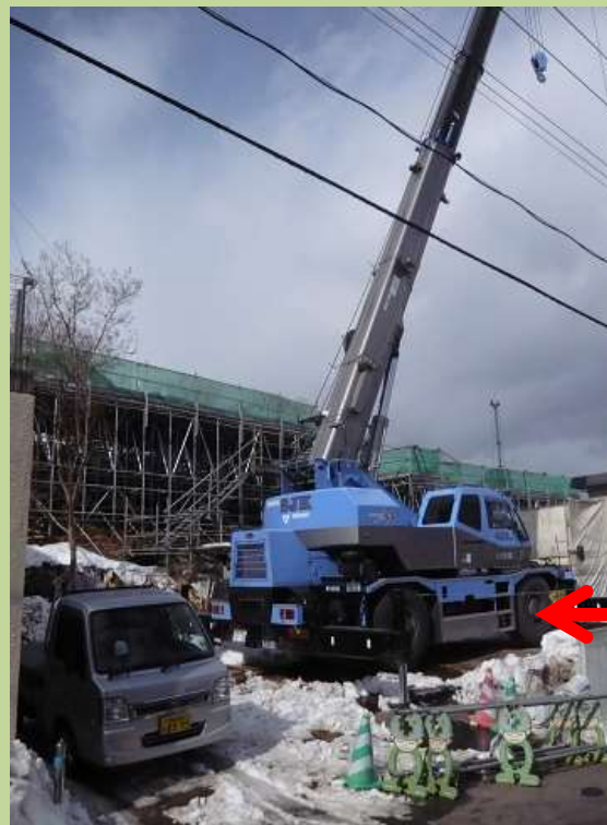
防災資機材倉庫は雪の中
