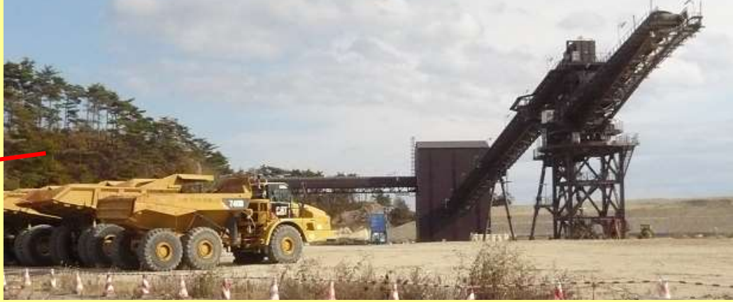
ここでもベルトコンベア方式による嵩上げ工事
