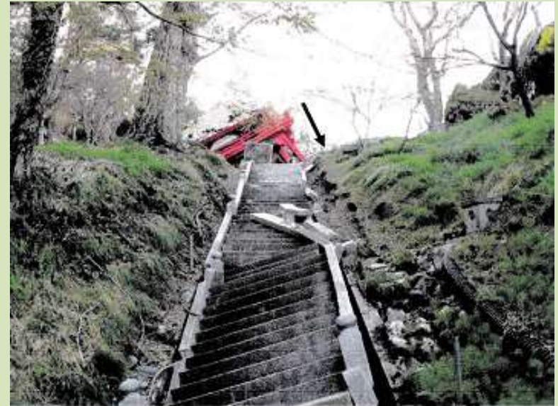
地表地震断層(矢印間)が通過した参道と倒壊した山門。
