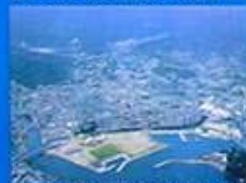
広湾上空からみた広川町広地区の海岸 広湾の埋立地の中央に町役場の新庁舎が見える。津波や高潮に備えて、埋立地は高さ7mのコンクリート護岸で囲まれており、右側の江上川河口には水門が設置されている。
