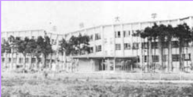
校舎南面の被災状況
