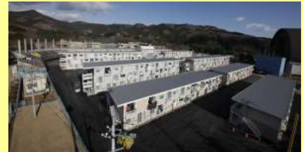
坂茂氏の設計で野球場内に建設された3階建て仮設住宅
