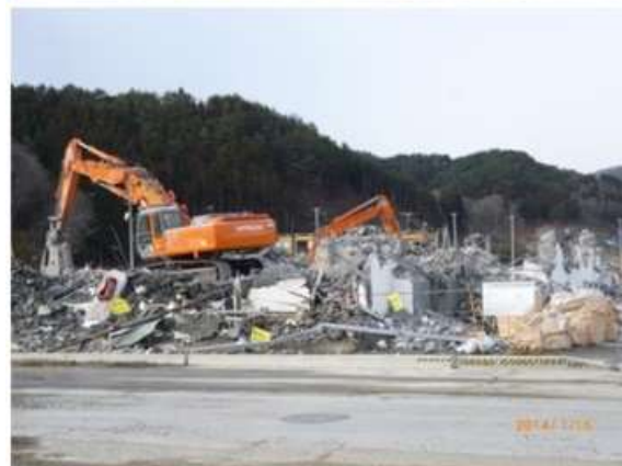
遺族の会の祭壇、解体中の防災センター(上) 遺族の会が設けた祭壇、(下) 解体中の鶴住居地区防災センター(2014年1月16日撮影。現在は更地/写真提供:齋藤徳美氏)
