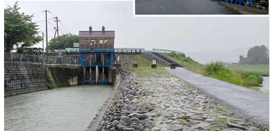
大石取水水門
