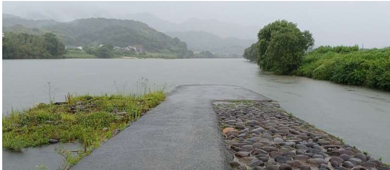
大石取水口から上流側を見る
