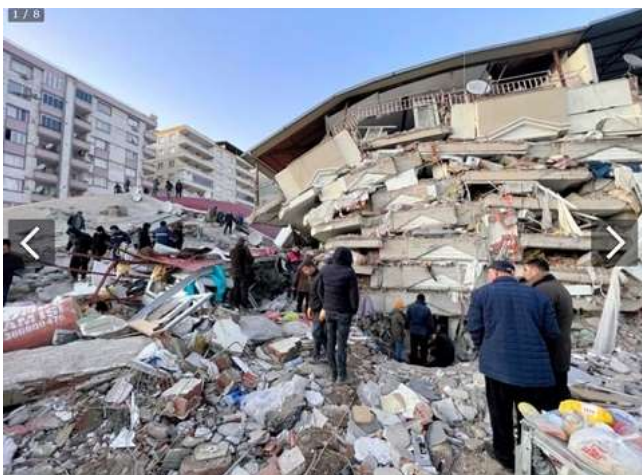
上層から下層まで押しつぶされたアパートの1棟。1階部分には商店が入居していたというがまったく痕跡がなくなっていた=2023年2月7日、トルコ南部カフラマンマラシュ
