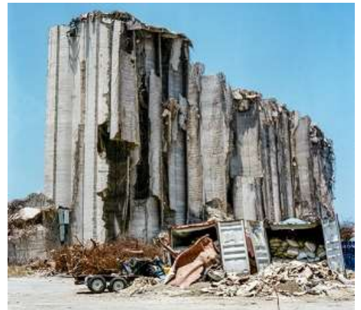
ベイルート港に立つ穀物サイロ。これが爆発の衝撃を受け止めたため、街の西半分は広範囲の損傷を免れた。(PHOTOGRAPH BY RENA EFFENDI)
