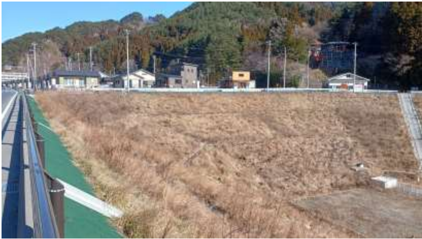
嵩上げされた高台上に建設された復興住宅
