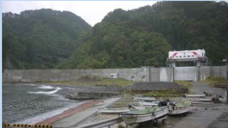
海辺の漁港から防潮堤を望む
