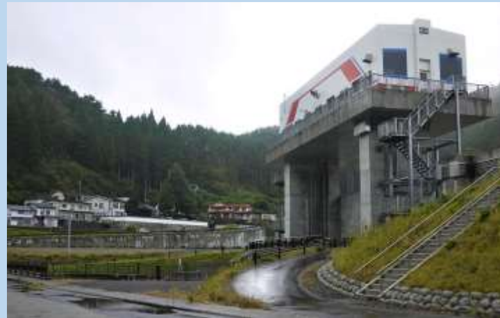
防潮堤付近の斜面に張り付いた集落
