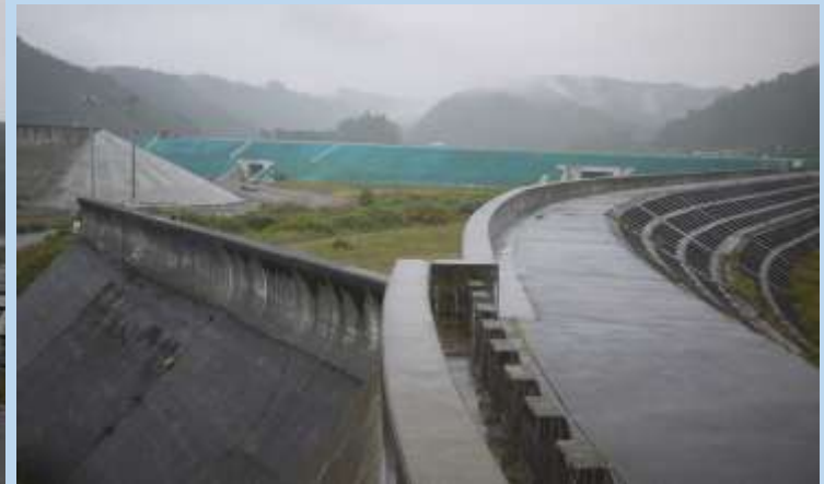
複雑に重なる田老町の防潮堤
