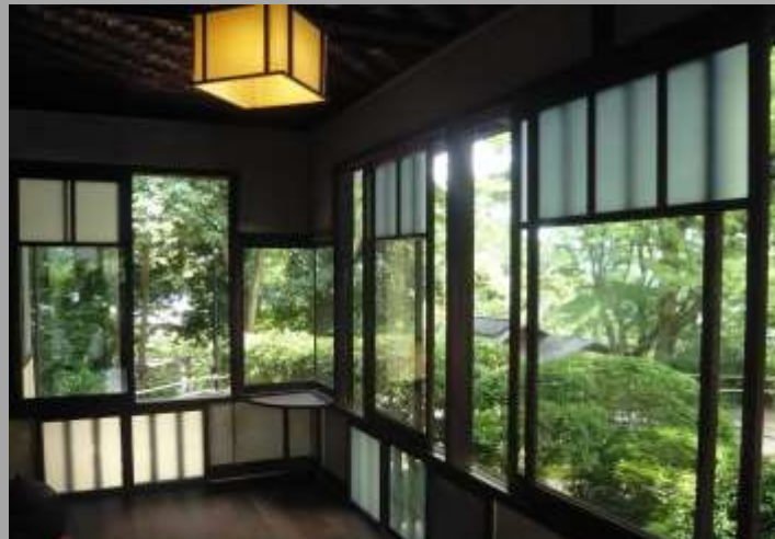
ガラス2枚が破損したが建付けに狂いは生じなかった
