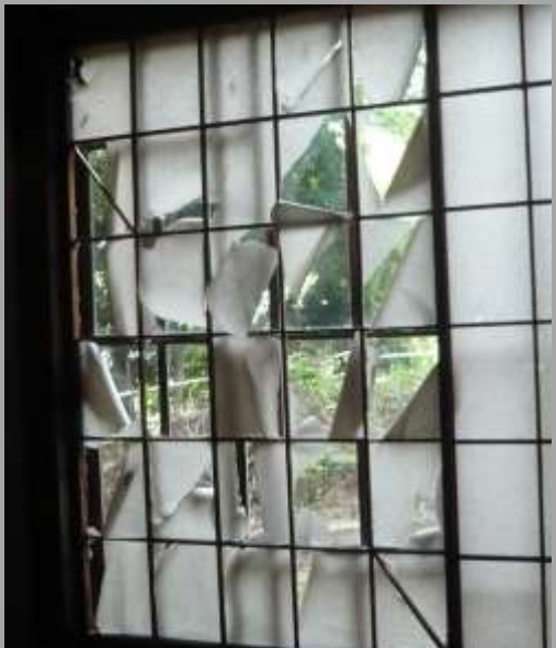
障子紙の破れや壁の亀裂は短周期地震動の特徴である
