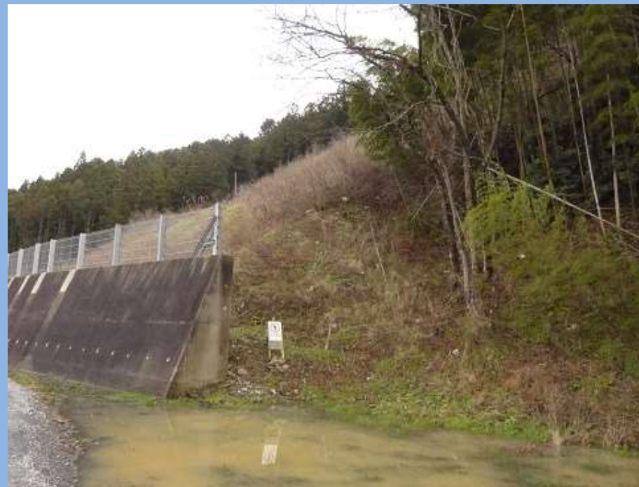
フラットデッキ (斜面崩壊予防のためのコンクリート工事)
