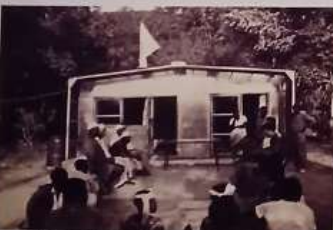
1962年、タンザニアの「島」タンザニアに存在する調査拠点を完成させた。 In 1962, the research station which was established in Tanganyika (Tanzania).
