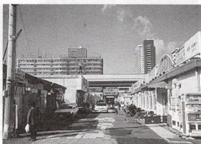
写真8-a 新長田駅南の大正筋。後方右は強震記録が観測された住都公園住宅、左は被害甚大のスカイビル(1998.1)
