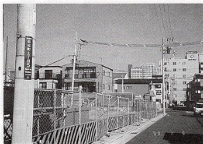
写真7-b 同上。漸く6階建て店舗付共同住宅の工事(1999.1)
