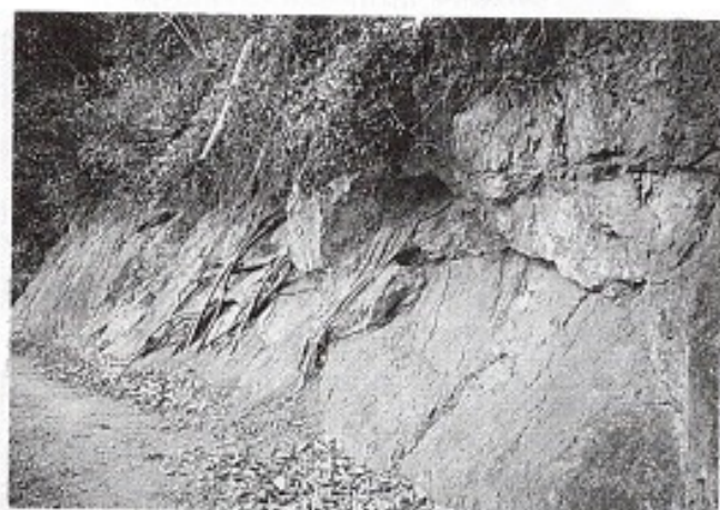
写真2 新神戸駅裏の散策路に見られる風化花崗岩(1999.1)
