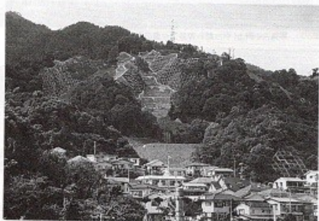
写真1-b 同上。1年後に防災工事は完了した(1998.7)
