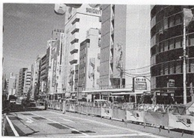
写真4 三宮駅南では地下鉄海岸線の工事中(1998.6)
