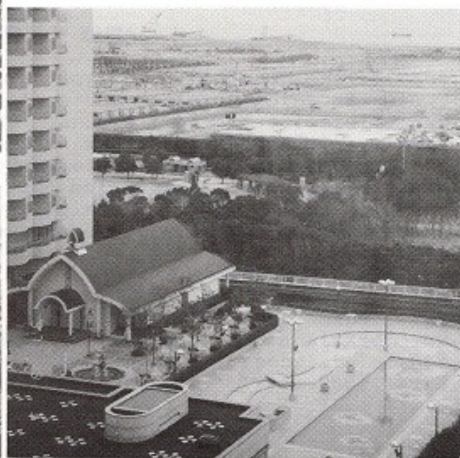
写真18 ポートアイランドの高層ホテルと その海側の仮設住宅群(平9.3.)
