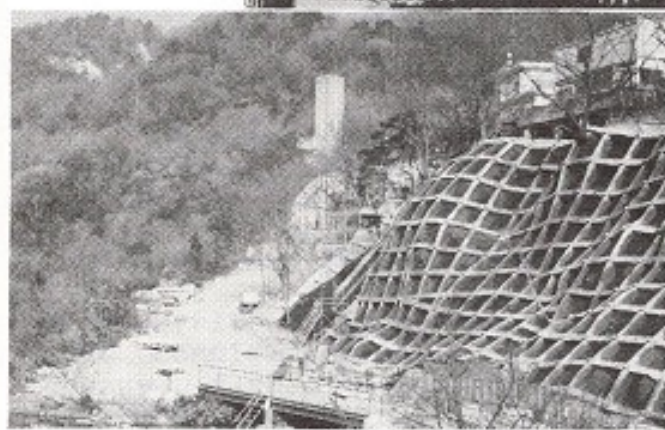
写真17-a 住吉川上流崖地の防災工事(平8.12.)
