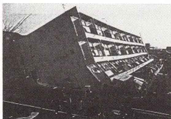
写真6 夙川マンションN(西より)
