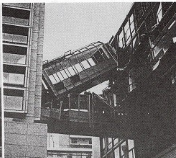
写真1-b 神戸市役所連絡橋(東より)
