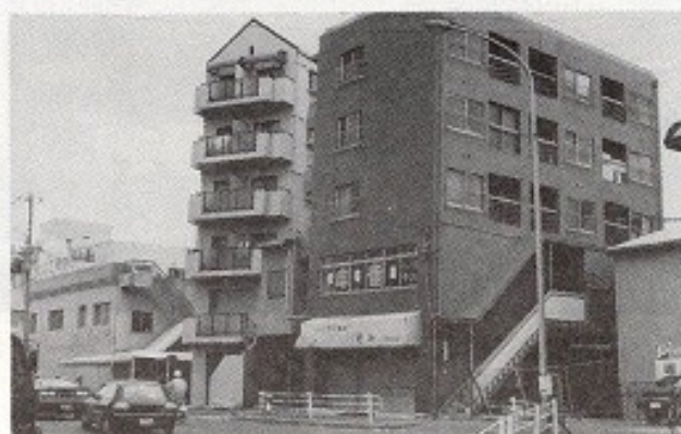
[写真17] 鷹取駅南口の建物にはさほど大きな被害は認められない(須磨区行平, 6/3撮影)。
