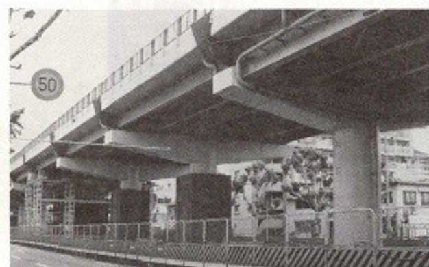
[写真19] さらに南の阪神高速では柱の補強工事が行われていたが被害は差程でもない(同左)。
