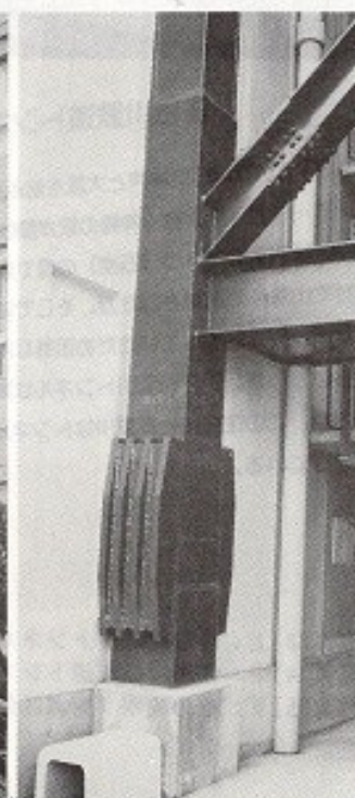
[写真22] 同じく1階脆性破壊箇所の補強状況(同左)。
