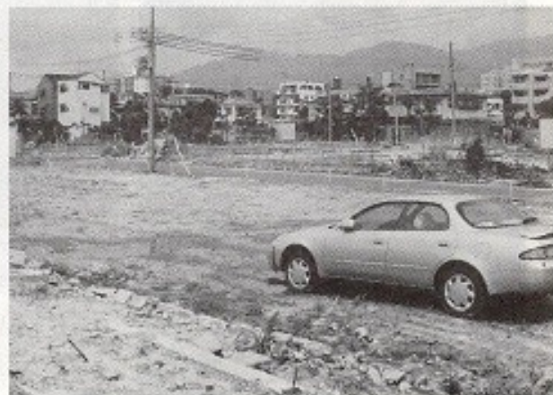
[写真15]同じ魚崎北町一帯の取り壊し完了後の状況（6/4撮影）
