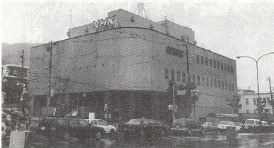
[写真 1]地震時のビデオ画像が撮影されたNHK神戸放送局の概観。RC4階建の建物は近々取り壊される予定になっているとのこと（中央区中山手通，6/3撮影）。
