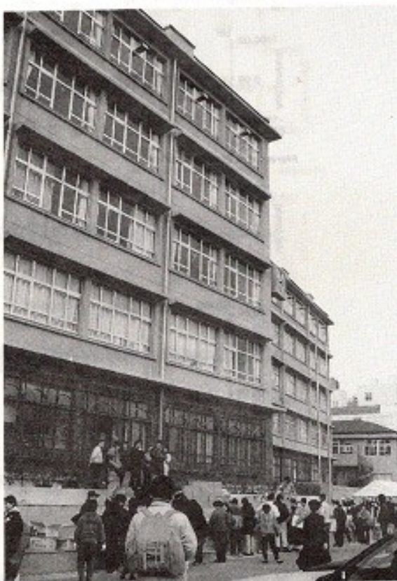
【写真22】学校建築の被害は一般に軽微であり、避難所として貴重な存在になっている（中央区北長狭通，1/28撮影）。
