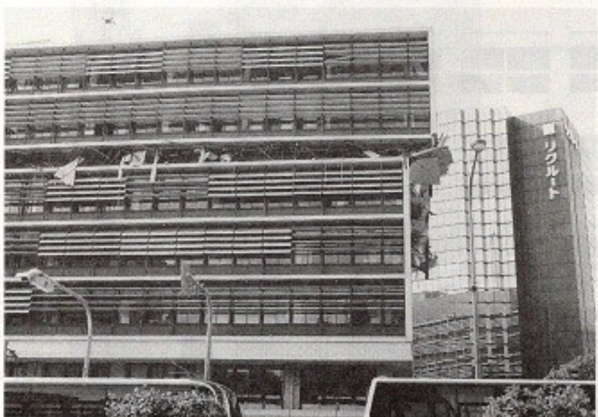
【写真 9】神戸市役所旧館の被害（中央区，1/28撮影）。6壊部分が長軸方向(北側)に圧壊している。隣接するリクルートビルや高層の新市庁舎には被害の痕跡は見られない。
