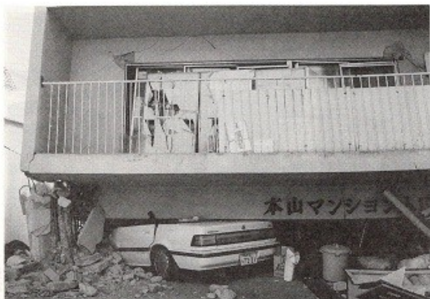
[写真13] JR摂津本山駅南側で1階部分が圧壊した本山マンション（東灘区田中町，1/29撮影）。1階はガレージとして使用されていた。この付近にはRC造マンションの被害が特に集中している。
