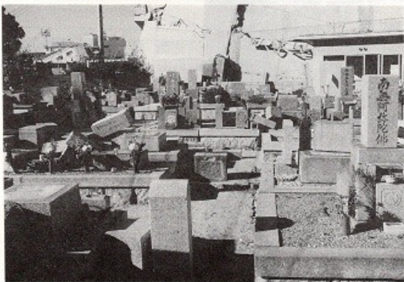
【写真18】灘神戸生協配送セン ターの被害（東灘区甲南町， 1/29撮影）。天上川を挟んだ 手前の墓地は壊滅状態で礎石 まで転倒しているものもある が，希には転倒を免れた墓石 も見受けられる。
