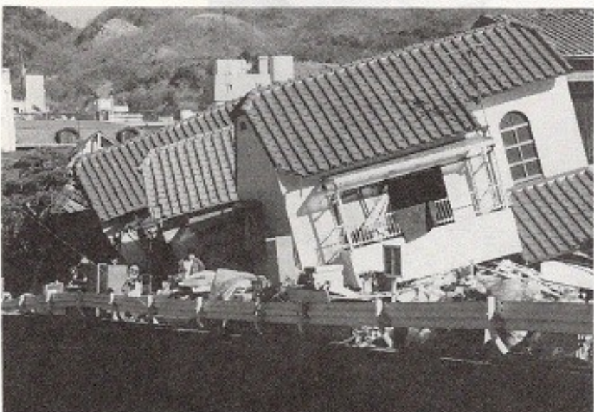
【写真17】このような事態に直 面するとカメラを向けること すら憚られ，遠方からズーム で撮影する（東灘区田中町， 1/29撮影）。天上川に沿って 被害集中が見られる。
