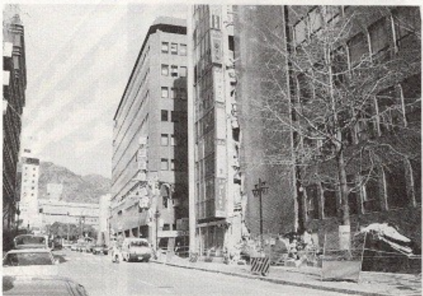
【写真 8】三宮ビル北館(奥)と南館(手前)の被害（中央区，1/28撮影）。北館は3階部分が，南館は1階部分が夫々圧壊している。
