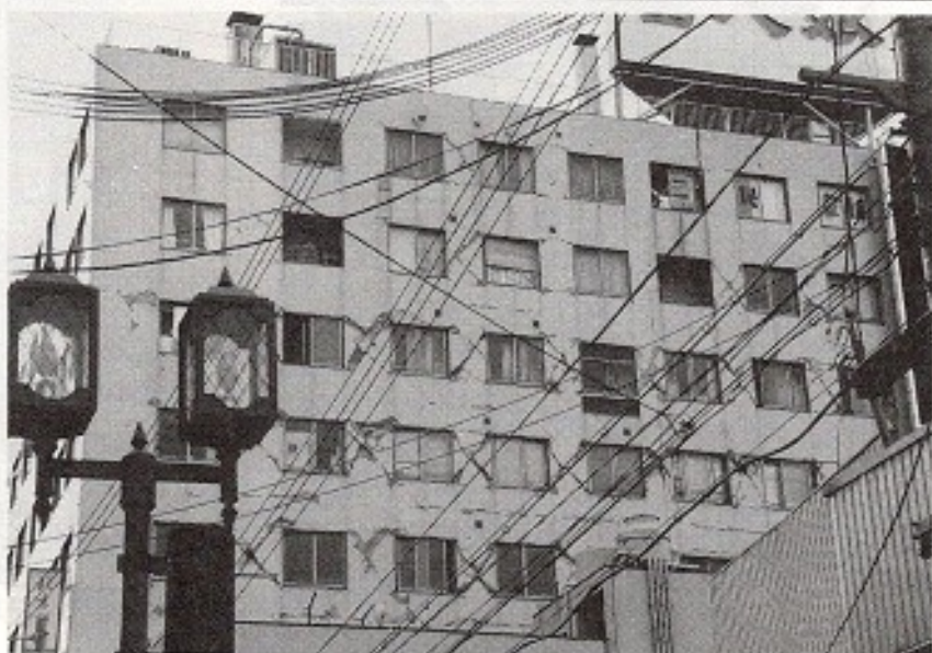
【写真11】元町プラザビル壁面のせん断亀裂（中央区元町通，1/28撮影）。大破には違いないが，合理的とも思えるこの種の破壊形態は，人的被害を与える危険性は少ない。
