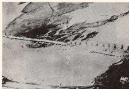
写真九 馬入川における橋梁の被害(手前が鉄道橋)
