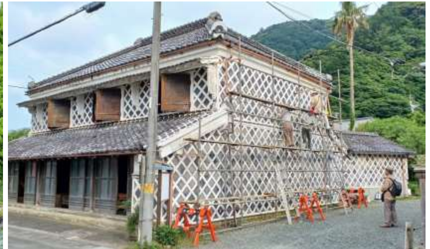
ナマコ壁の補修工事現場
