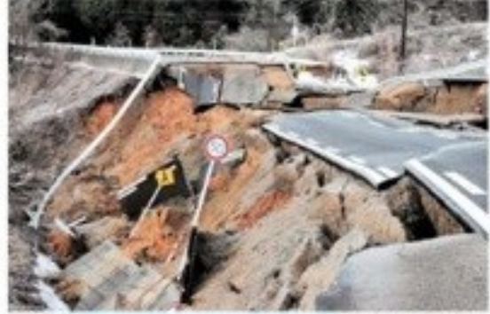
県境結ぶ国道寸断
