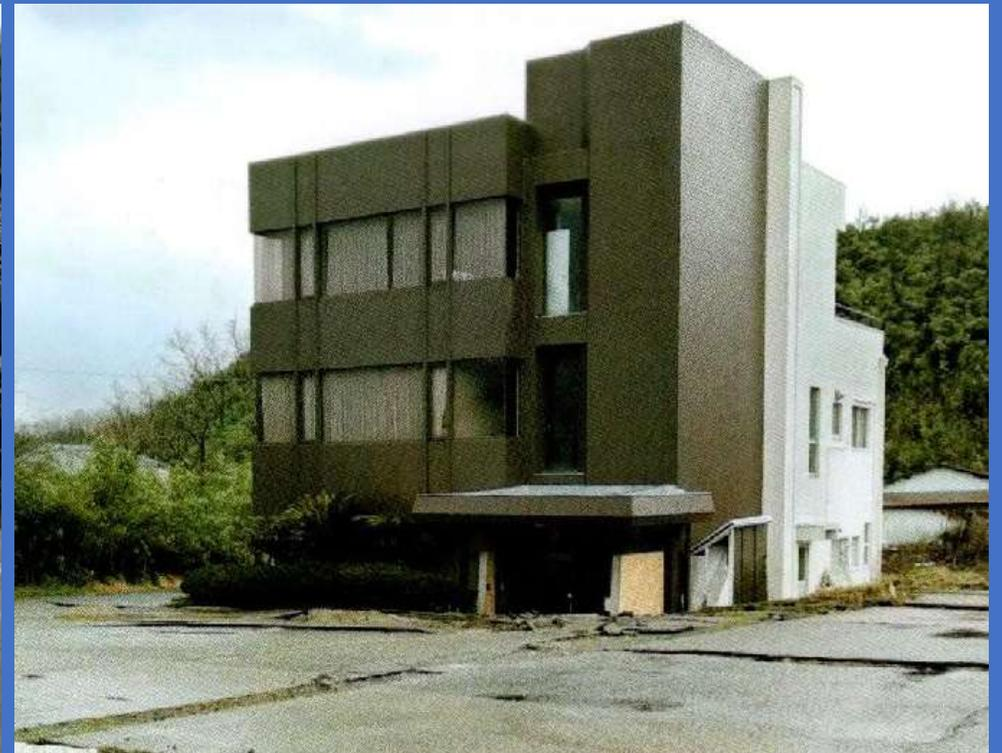
液状化によって1階の半分が地盤に沈んだビル(内灘町西荒屋)
