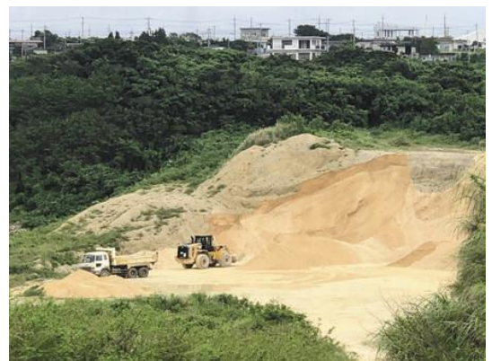
防衛省が3つの弾薬庫と射撃訓練場などの建設を予定する保良鉱山の採石場。すぐ後ろには民家が立ち並ぶ=3月10日、沖縄県宮古島市周辺保良で
