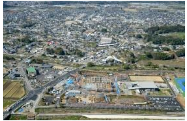
熊本地震からの復興途上にある熊本県益城町=3月12日(本社ヘリから)
