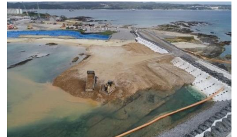
辺野古で進行中の埋め立て工事、沖縄タイムスの記事より
