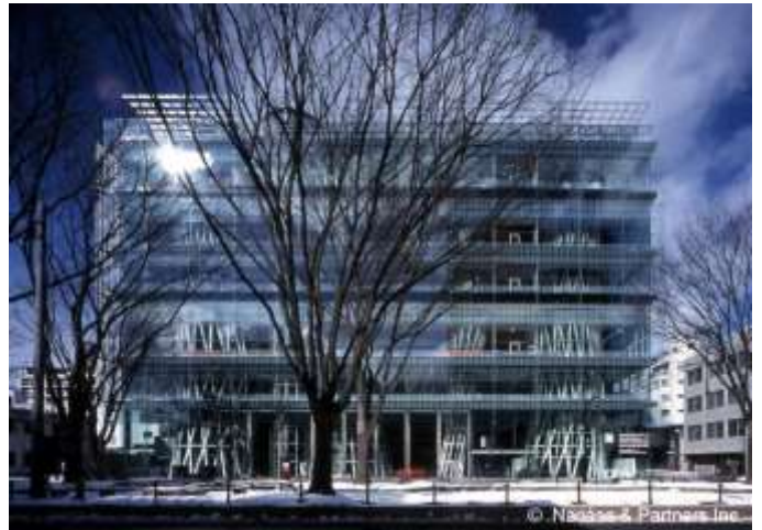
写真：伊東豊雄建築設計事務所 HP より引用
