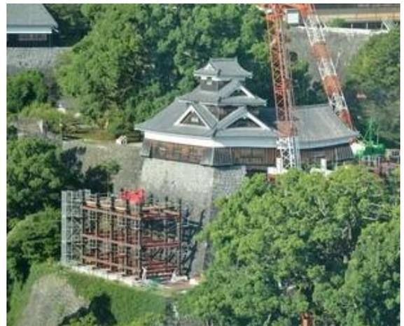
石垣の復旧工事のため一時解体される熊本城の飯田丸五階櫓
