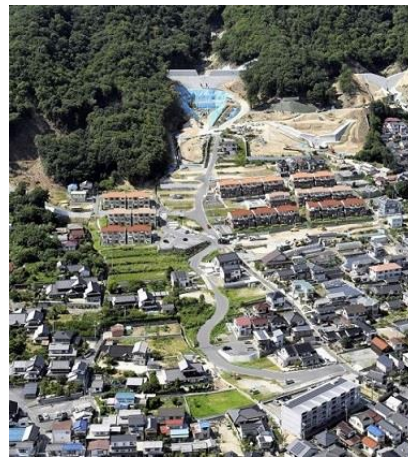
広島土砂災害から3年が経過し、復興が進む広島市安佐南区八木地区の住宅地。山裾に砂防ダムが完成した=2017年8月19日、毎日新聞社ヘリから撮影
