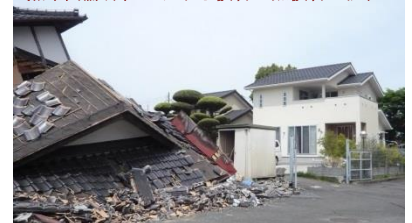
熊本益城町における被害・無被害の混在(1)
