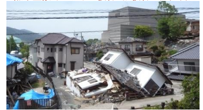
熊本益城町における被害・無被害の混在(2)
