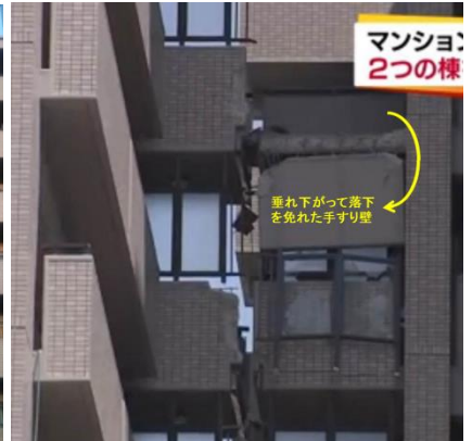
016年(平成28年)4月16日(土 後日) 地震の影響で亀裂が入ったマンションの廊下 廊下=15日午後4時5分、熊本市中央区で
