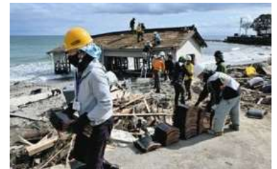
津波で流された家屋の解体作業をするボランティア＝石川県能登町
