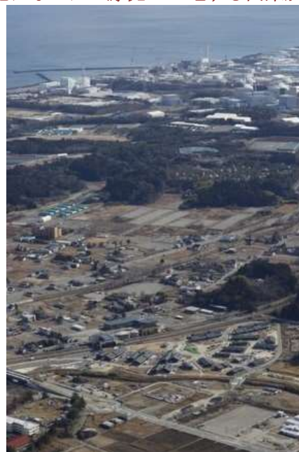
福島県双葉町。手前中央はJR双葉駅。奥に東京電力福島第1原発が見える＝2024年2月11日、本社ヘリから
