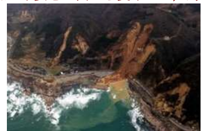
能登半島地震では土砂崩れが相次いだ。大規模な土砂崩れで寸断された国道249号=2024年1月5日、石川県珠洲市、朝日新聞社へリから
