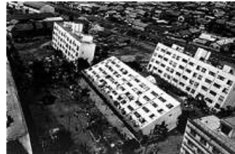
1964年6月16日の新潟地震で倒壊した県営の鉄筋アパート=1964年6月17日、毎日新聞社ヘリから
