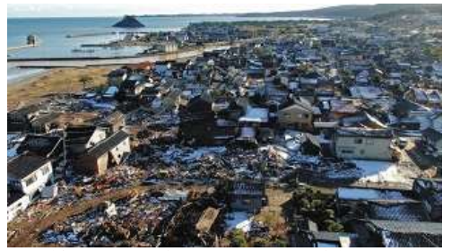
地震や津波で甚大な被害を受けた石川県珠洲市宝立町周辺。左奥は見附島=1月17日、ドローンから
