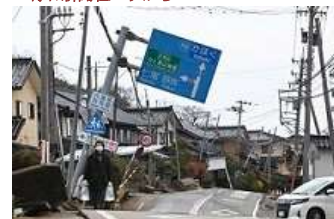
金沢市に隣接する石川県内灘町は液状化により大きな被害が出ている。土地が隆起し道路や家屋が大きく傾いている=2024年1月19日
