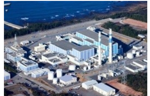
志賀原発=2024年1月2日、石川県志賀町、朝日新聞社機から
