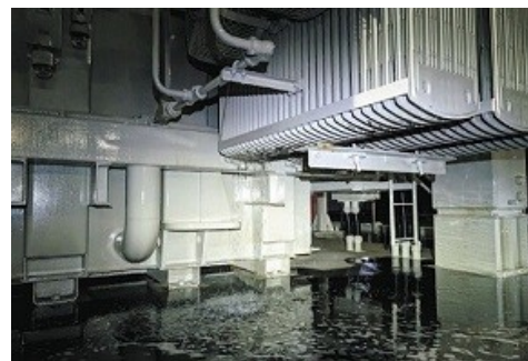
地震による揺れで油漏れを起こした北陸電力志賀原発1号機の変圧器=1日(北陸電力提供)
