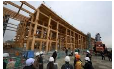
建設中の2025年大阪・関西万博会場の大屋根「リング」 =大阪市此花区で2023年11月27日
