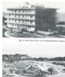
1960年アガディール地震で崩壊した4階建てホテル。上:地震前、下:地震直後
