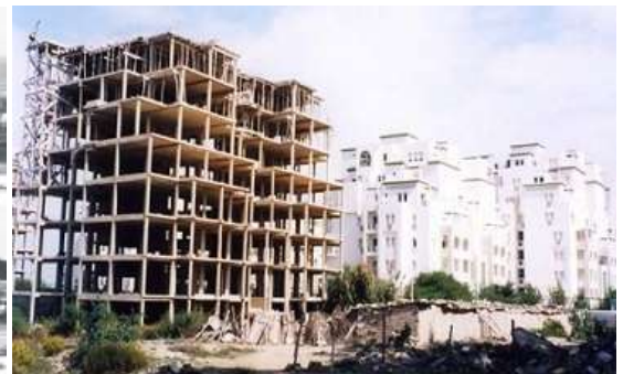
共同研究でモロッコを訪問した際にテトワンで撮影した集合住宅。手前が建設中の建物で、背後に見えるのが完成後の建物。建設中の建物を見るとその構造が非常によく理解できる。(1998年撮影)
