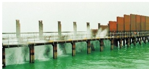
潮受け堤防の建設へ向け、湾を閉め切る鋼板が次々と海に落とされた。「ギロチン」と呼ばれ、干潟保全の運動に拍車をかけた =1997年4月14日、長崎県諫早市
